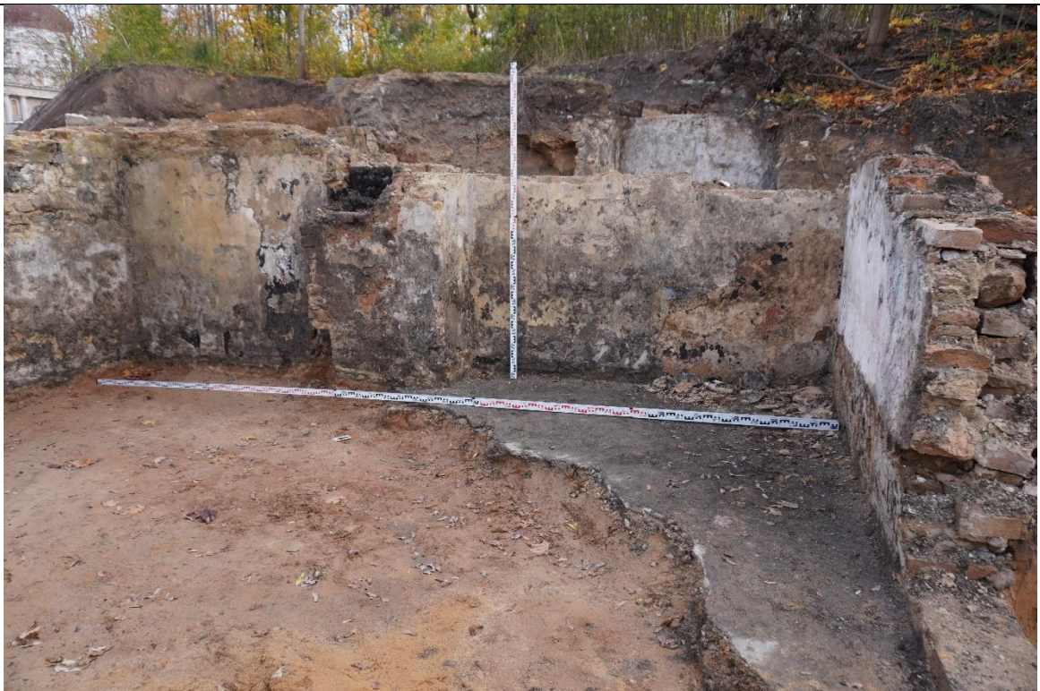
F.44. Pastatas P3. Patalpa nr.2 – PR siena. Grindų fragmentas ir buvusio kamino vieta. Vaizdas iš ŠV pusės.
