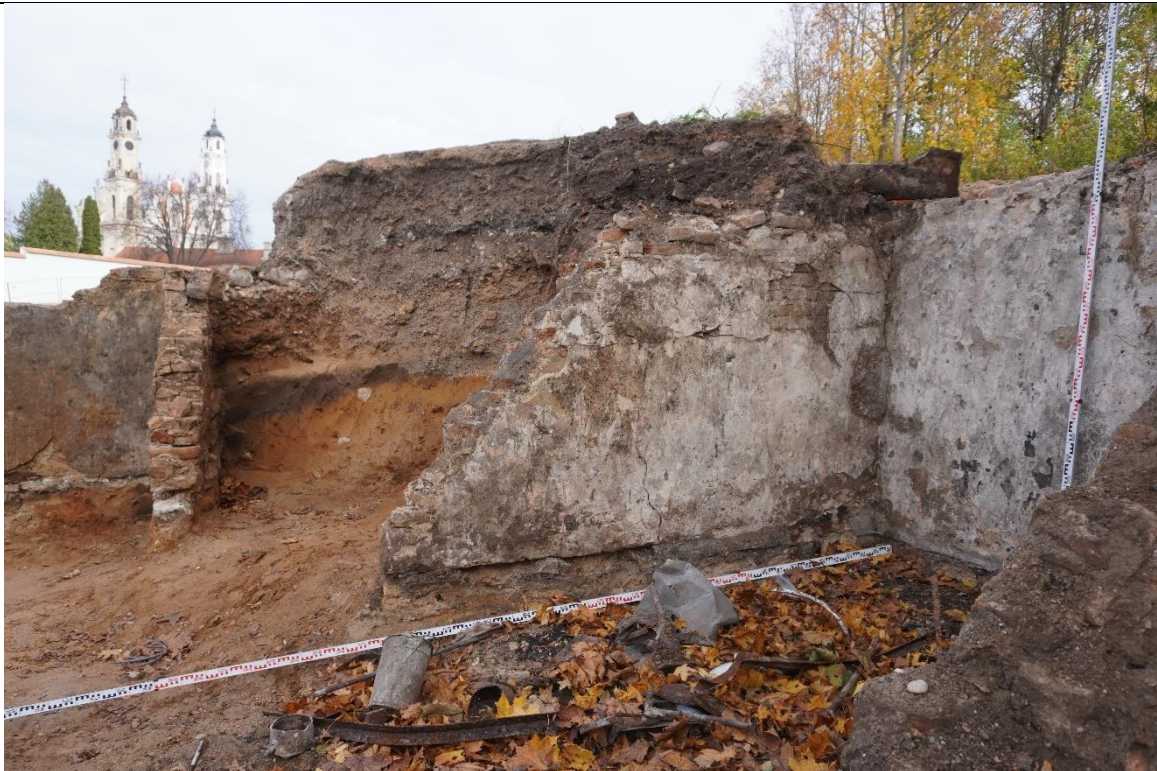
F.47. Pastatas P3. Patalpos nr.4 sienų liekanos. Vaizdas iš V pusės.
