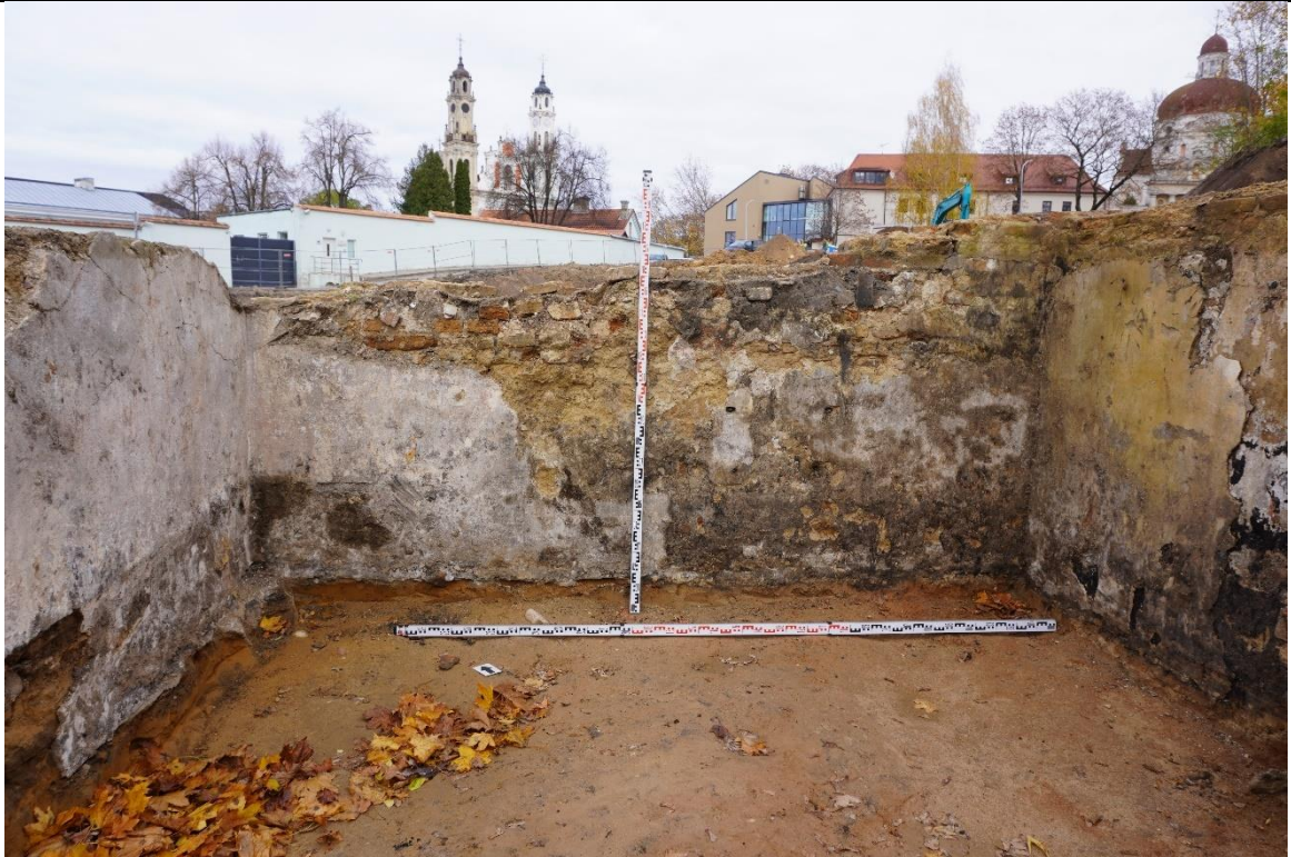
F.43. Pastatas P3. Patalpa nr.2 – ŠR siena. Vaizdas iš PV pusės.
