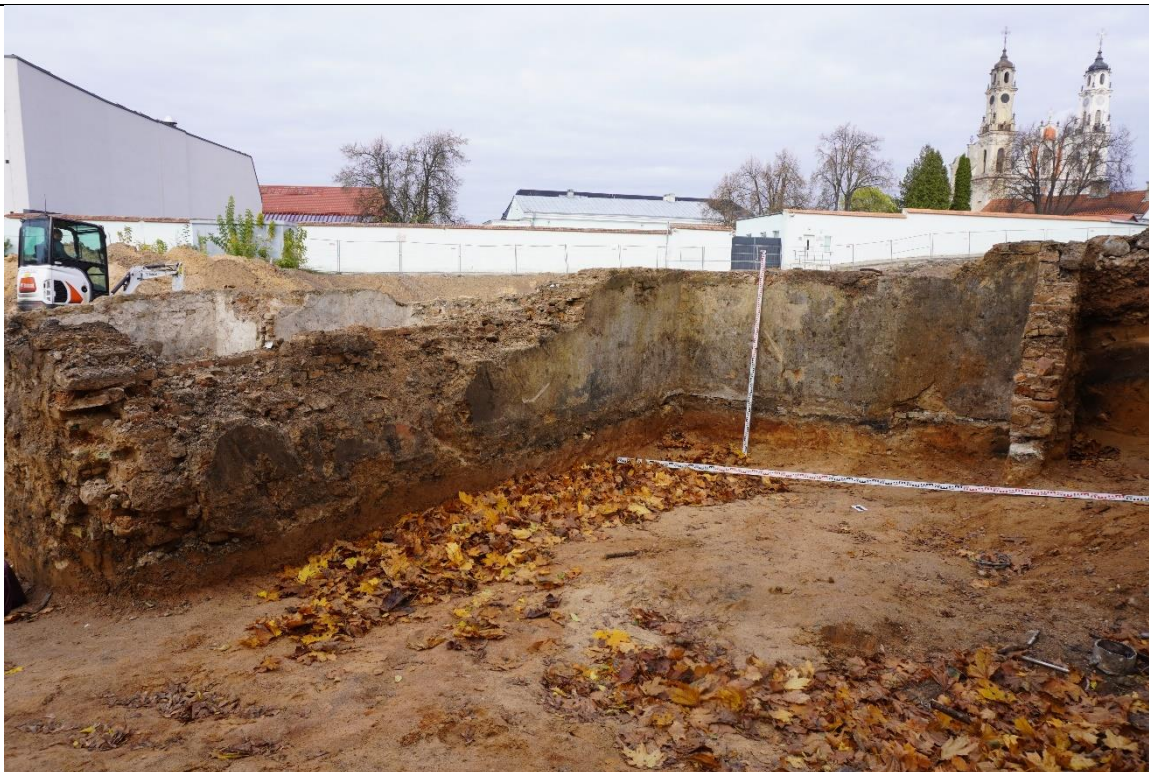
F.46. Pastatas P3. Patalpa nr.3 – ŠV ir ŠR sienos. Vaizdas iš R pusės.
